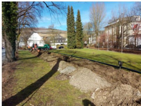
Kabelverlegung im Park
