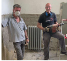
Olaf Hentschel und Markus Sommer bei Abrissarbeiten
