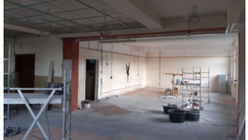
Hier entsteht der große trennbare Raum.
