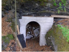
Eingang zum Stollen
