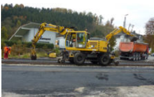
Bahnübergang Kirchstr. Ost
