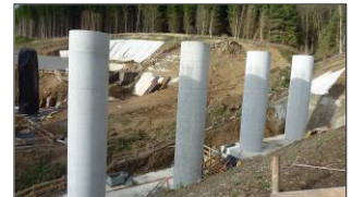
Brücke Sengenberg am 9.11.2013
