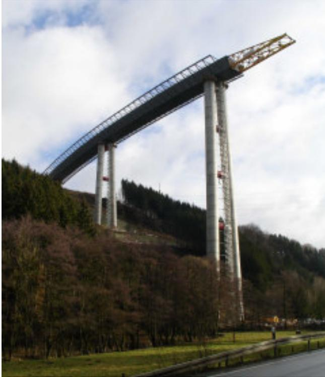
Während der Vorbauschnabel mit der Stahlkonstruktion den höchsten Brückenpfeiler der Talbrücke Nuttlar bereits hinter sich gelassen hat, geht es mit der Planung der L 776 neu zwischen Evenkopf und Autobahn sehr zum Unmut der Nuttlarer Bürger nicht so zügig voran, wie in der Vergangenheit immer wieder versichert.
