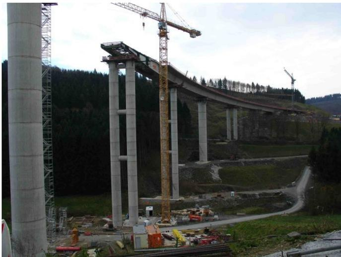
Die Brücke liegt in einer Kurve mit einem Radius von 450 m.
